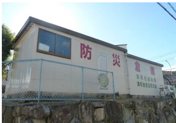
自治会・自主防災会所有の防災倉庫
